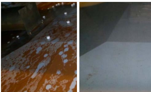
► Voor en na chemische reiniging koeltoren (Bron: Kalsbeek).
